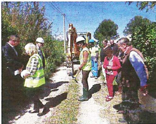
Coup d'envoi hier des travaux de raccordement au réseau d'eau en présence d'élus, de représentant de la SPL « l'Eau des collines » et de riverains. M.C.
